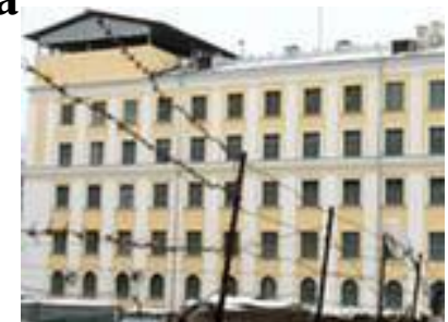
Gefängnis Krankenhaus Matrosskaya Tishina
